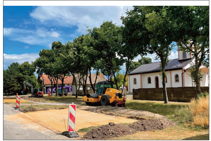
Изградња паркинга код нове цркве
